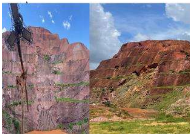
Figure 2 : Talus affaissés (source : données d'enquêtes 2024)
