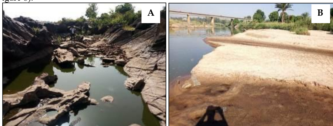
Figure 8. Morphologie des berges la Kara (Source : travaux de terrain, 2025)
