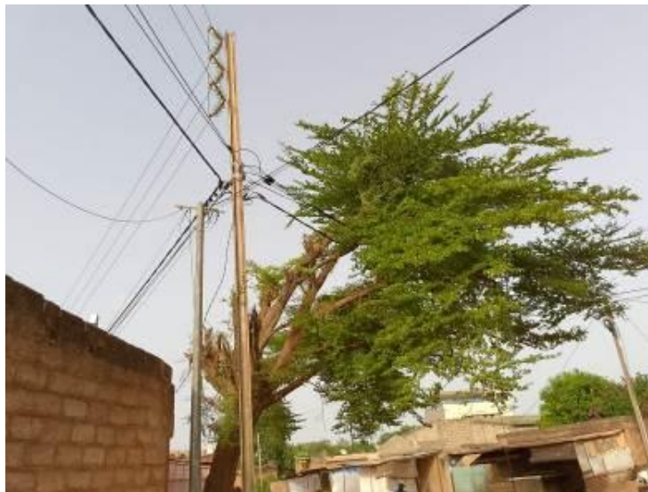
Figure 15. Infrastructure électrique (haute tension), obstacle aux plantations d'alignement (Source : ZABRE N. G., Mai, 2024)
